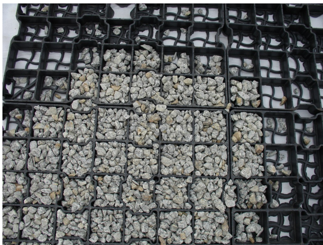
Geokrata wypełniona grysem.
