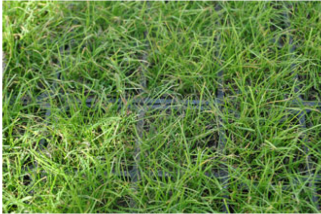
Geokrata wypełniona ziemią (zasiana trawą).
