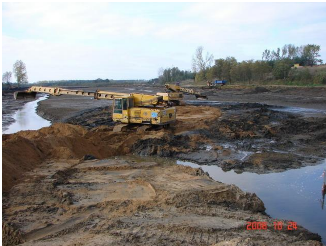
Fot. Nr 4. Czyszczenie i pogłębienie zalewu.
