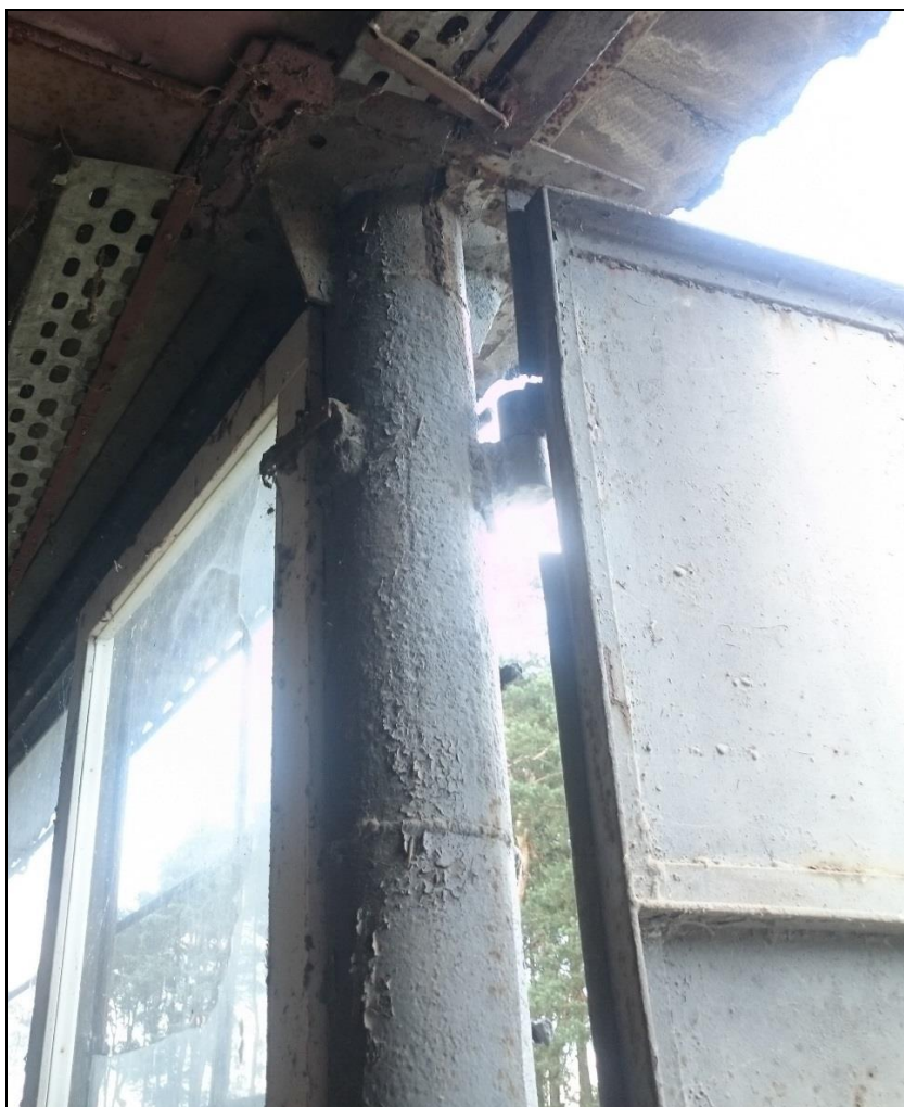
Ryc. 5. Słup z blachą węzłową
